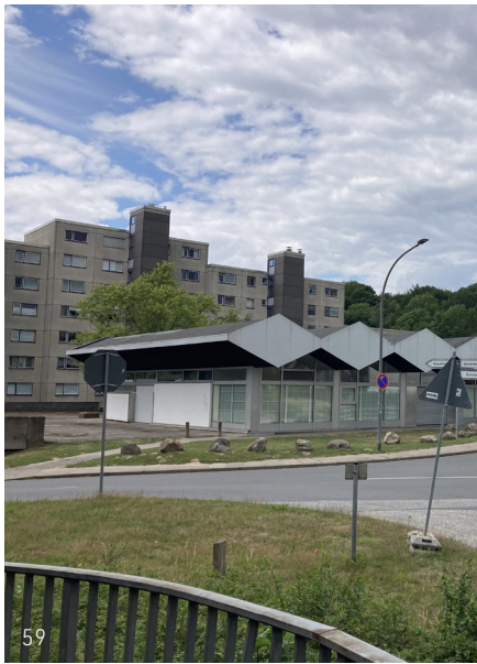
59 / Modernisierungsbedarf der Siedlung Am Kurpark
